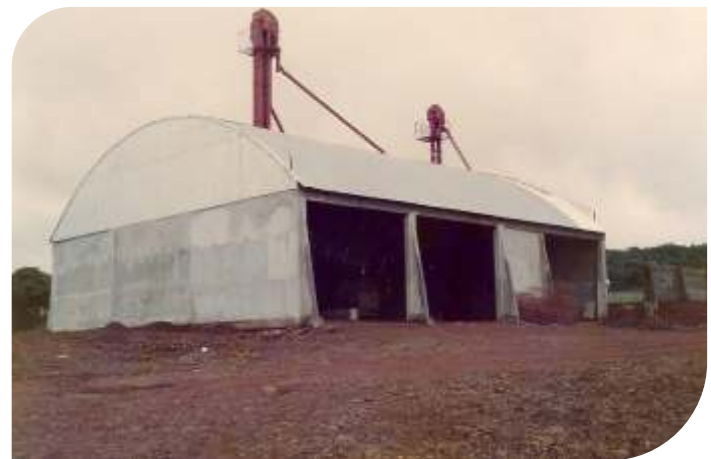
Construção das primeiras moegas, também em 1984
