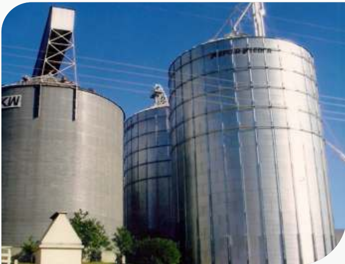
Primeiros silos construídos eram em estrutura metálica.
